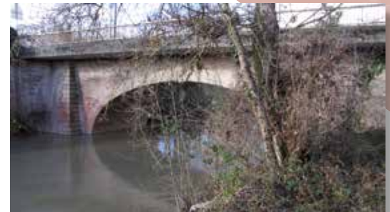
Toulouse, Pont des États sur le Touch SI 11/12/1942
